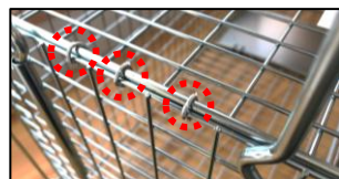
前扉接続部のリング
